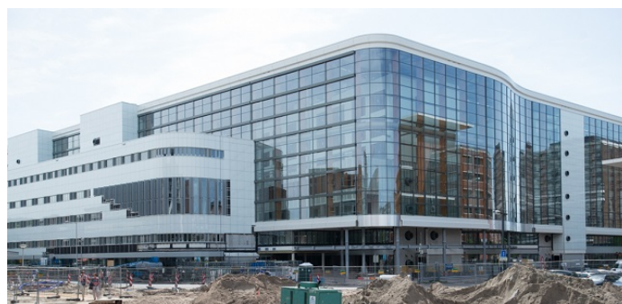
Figuur 9: Frontaal aanzicht van het in aanbouw zijnde nieuwe Medisch Spectrum Twente te Enschede
