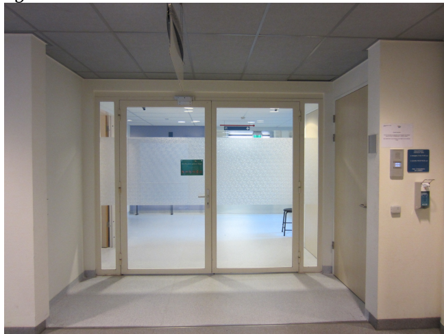
Figuur 35: Toegangsdeur voor de afdeling Intensive care in het Medisch Spectrum Twente te Enschede. Aan de rechter zijde is op de muur de dispenser te zien om handen te desinfecteren en hier schuin boven de bel om de deur te laten openen.
